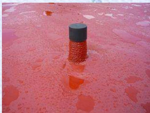
Los puntos singulares han de tratarse en primer lugar. El espesor medio del revestimiento fue de entre 1,5 mm y 2 mm. Este espesor se debe alcanzar en dos pasadas cruzadas.
