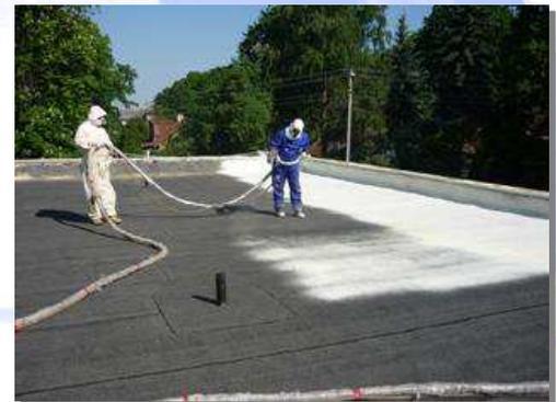
El espesor medio aplicado fue de 50 mm. La aplicación se realizó en 4 pasadas. La primera pasada a modo de imprimación (menos de 5 mm), y las siguientes sin superar los 20 mm cada una.
