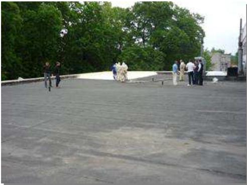
Previamente se ha limpiado y se han tratado todos los puntos singulares, aplicando posteriormente un adherente sobre las superficies metálicas con el fin de obtener una buena adherencia del poliuretano. Es esencial que las superficies estén limpias y secas.
