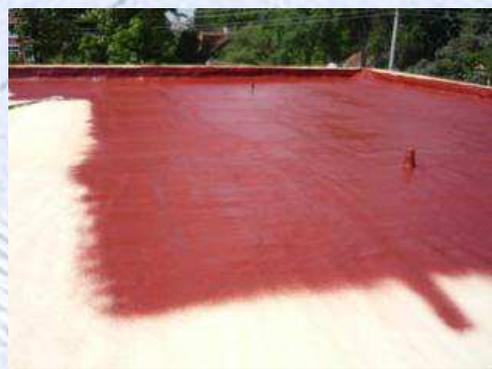
La aplicación del revestimiento se debe realizar sobre la superficie de la espuma en ausencia de humedad, por lo que se recomienda proyectar tras la proyección de espuma.
