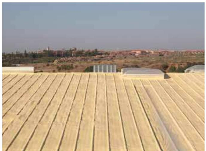
Cubierta inclinada con espuma de poliuretano proyectado
