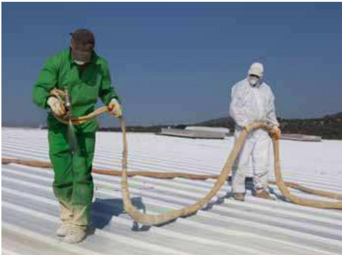
Aplicación de PUR proyectado sobre cubierta
