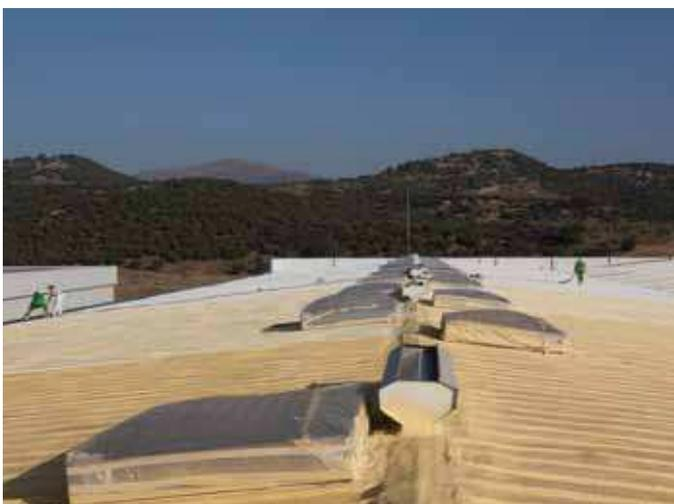
Detalle de elementos de la cubierta tras la proyección del PUR
