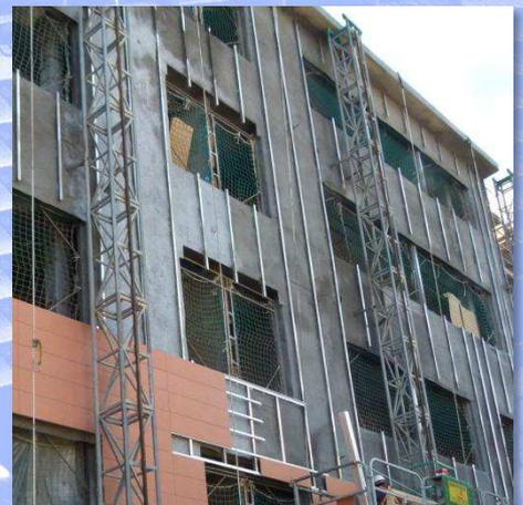
Proceso de instalación del sistema: Proyección de poliuretano, imprimación y proyección de mortero de protección.
