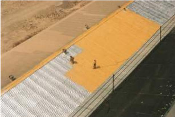
Con el fin de que la evacuación de agua quede garantizada y evitar su entrada entre el paramento y las ondas de la lámina de fibrocemento se recomienda integrar la proyección con los canalones, realizando un sellado previo entre la onda de la lámina y el propio canalón para posteriormente efectuar la proyección integrando el canalón en la cubierta.
