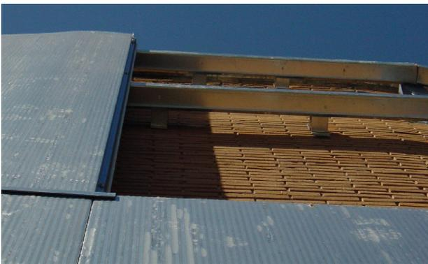
Fachada rehabilitada con paneles por el exterior
