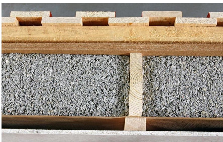
Aislamiento térmico entre rastreles de un suelo de madera
