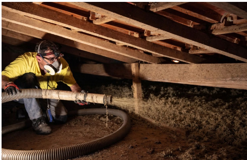
Aislamiento soplado bajo cubierta
