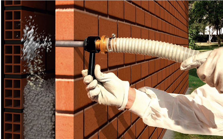
Aislamiento inyectado en cámara de aire de fachada
