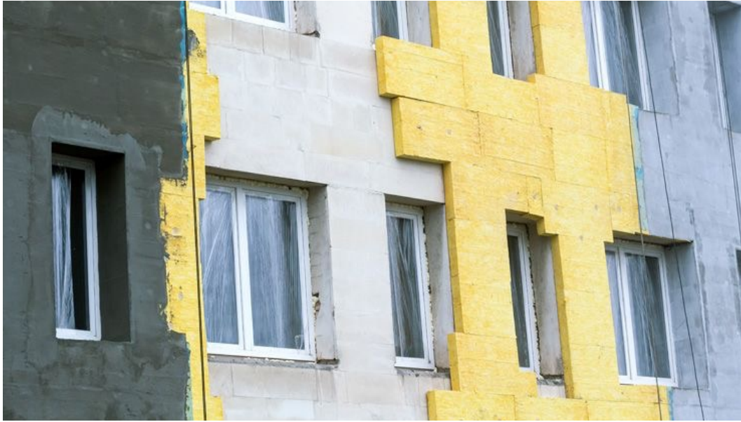
Rehabilitación energética de la envolvente de un edificio: Aislamiento y ventanas de PVC
