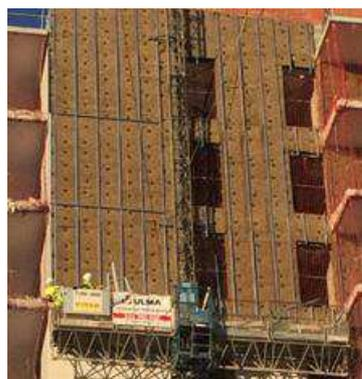
Fijación de 4.000 m<sup>2</sup> de lana mineral en la fachada ventilada del nuevo Edificio Gran Vía Terraces (Barcelona) con espigas CB
