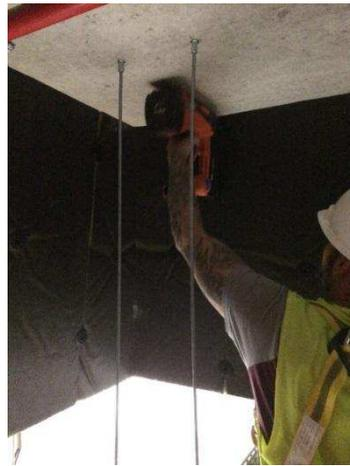
Clavado de 800 m<sup>2</sup> de lana de vidrio sobre los casetones del forjado de la planta parking de la Terminal de autobuses de Girona, con Pulsa 800E, Isogas y clavos HC6-32
