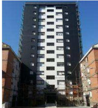
Rehabilitación del edificio Grupo Txurruka N2ºB en Trápaga (Vizcaya) con instalación de fachada ventilada fijada con el anclaje B-Long y aislamiento de 80 mm de lana mineral, clavada con la clavadora de gas INSULFAST
